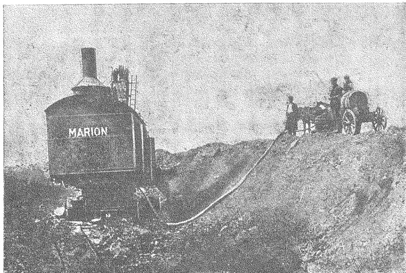
Фиг. 129. Постройка Турксиба. Питание водой экскаватора Marion-37 при помощи водовозных бочек.
