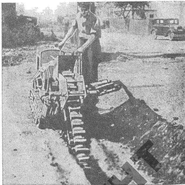
Фиг. 63. Многоковшевый экскаватор для рытья дренажных канав.
