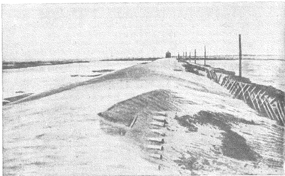
Фиг. 135. Сплошной песчаный занос на насыпи, высотой более 2 м.
