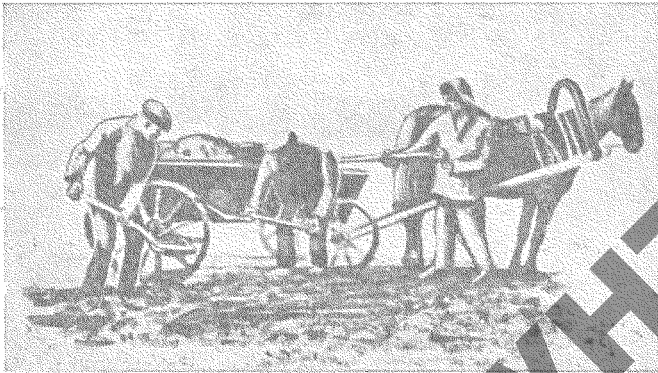
Фиг. 28. Расположение рабочих при нагрузке грабарки «тройкой»
