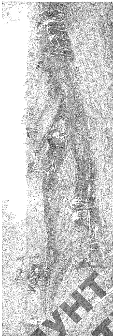
Фиг. 34. Обыкновенный скрепер-волокуша с ползьями, усиливающими дно.
