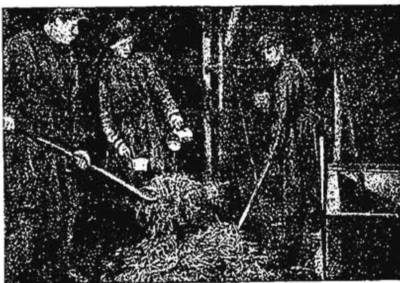
Фиг. 93. Перемешивание шерсти и стружки с вяжущим.
