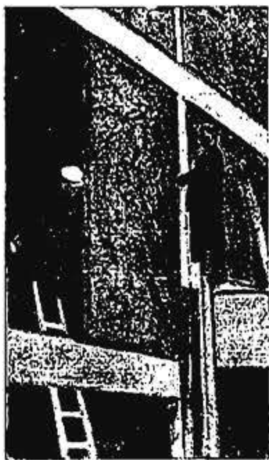
Фиг. 126. Применение соломита для заполнения деревянного каркаса (Германия).
