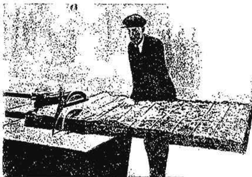
Фиг. 124. Распиловка соломитовой (камышитовой) плиты циркулярной пилой.
