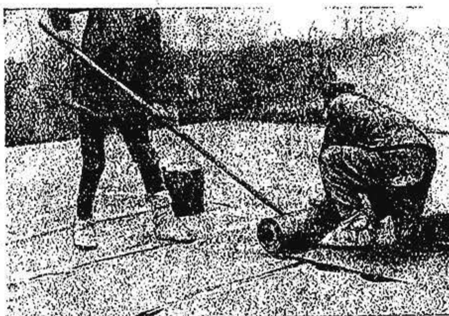
Фиг. 171. Покрытие плоской кровли пергамином по гольцементу.
