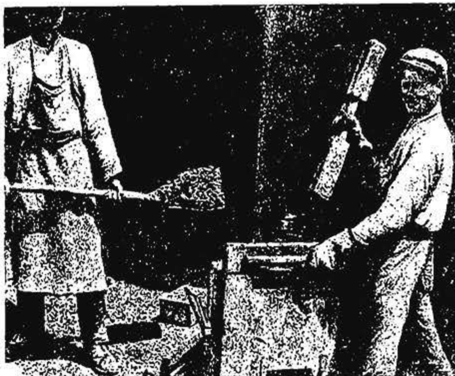
Фиг. 65. Насыпка формы бетоном и трамбование камня.
