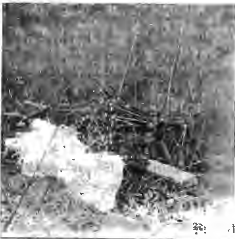
Фиг. 2. Фашина, прижившаяся и давшая отростки съ комля при засыпкѣ вершины грунтомъ. Видъ со стороны комля.
